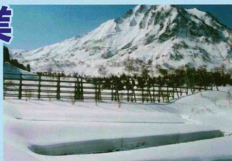
新潟県糸魚川市大字柵口 減勢工
