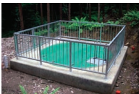
鳴の谷地 地すべり対策事業 B
