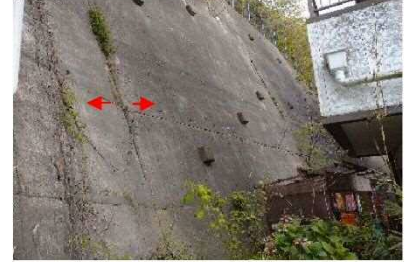
④擁壁開口状況
