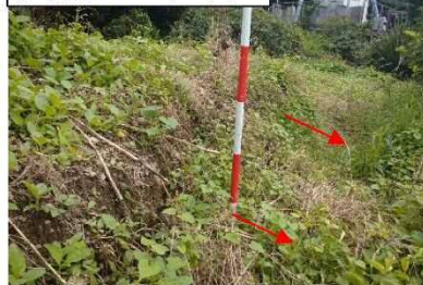
③滑落崖の段差状況
