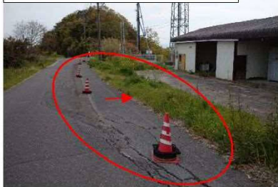
②斜面上部の農道破損状況
