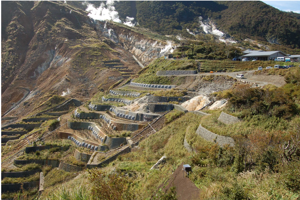
▲大涌沢上流部の地すべり地区 耐熱・耐酸性を考慮したアンカー工 (③ブロック)
