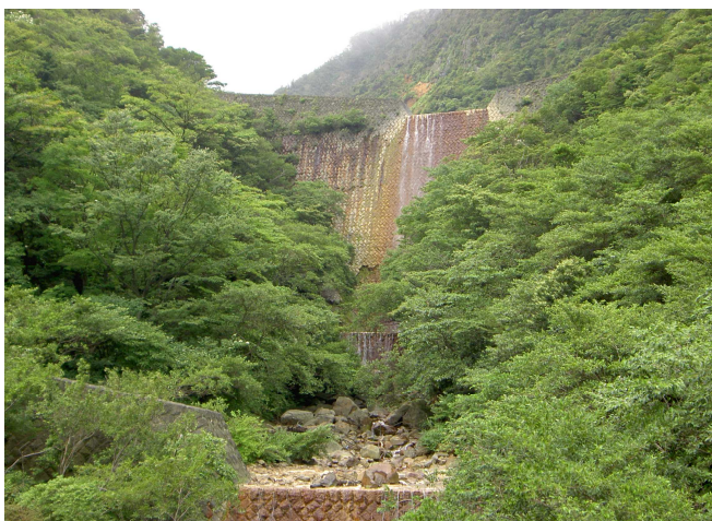
▲ 大涌沢中流部 地獄谷堰堤 耐震補強工事予定の砂防えん堤
