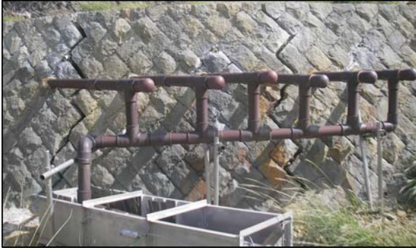
排水ボーリング工
