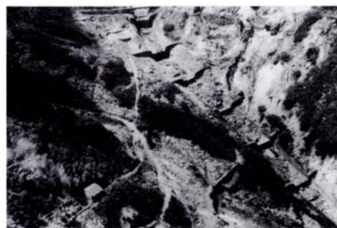
▲谷止工・水路工 (昭和33年当時)
