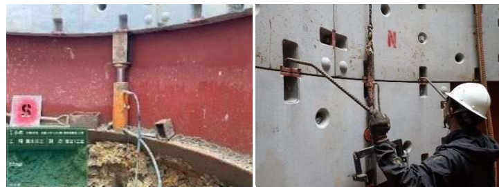
写真. 7 刃口沈設および RC セグメント組付状況
