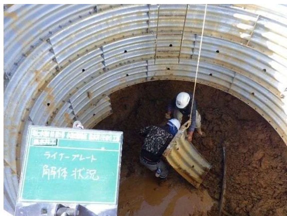
写真. 2 ライナープレート撤去
