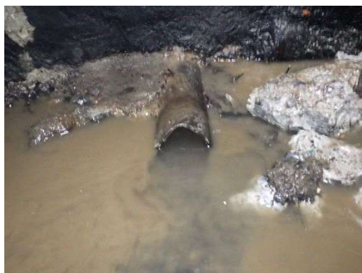
写真. 4 既設排水管 (φ100 mm)
