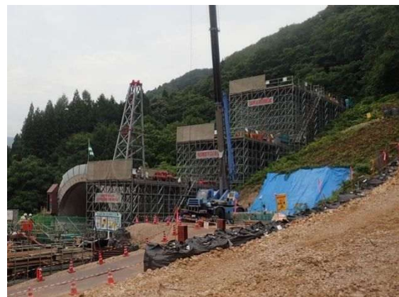
写真.1 システム作業構台+大口径ボーリング工
