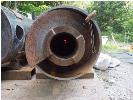
写真.6 ターゲット設置状況
