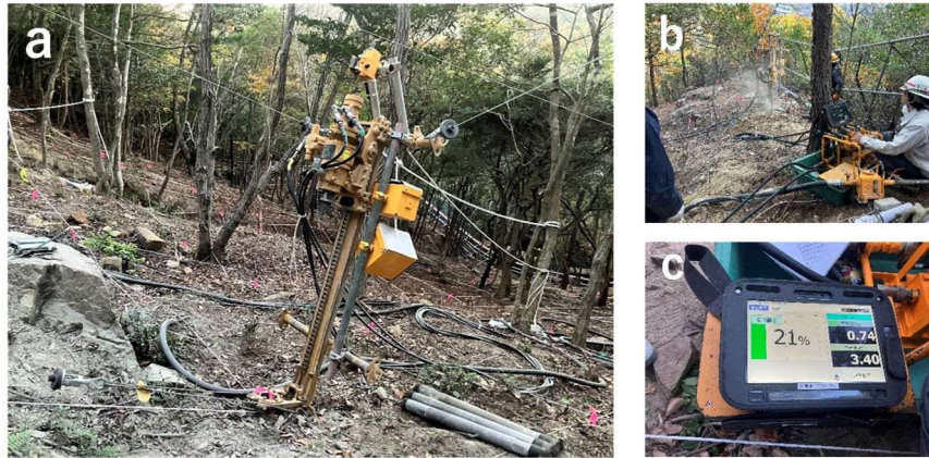
写真.2 無足場削孔機における ICT 削孔管理システムの活用状況 (a: 削孔機全景, b: オペレーターの操作状況, c: タブレットモニター)
