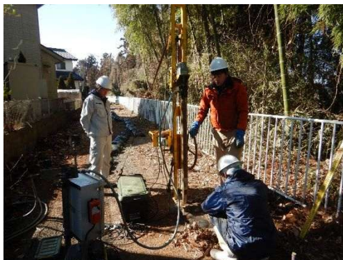
写真.4 掘削作業状況
