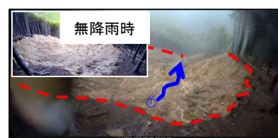
図. 7 豪雨時の崩壊地内
