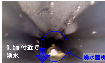
写真.4 横ボーリング Y-1 6.5m 付近
