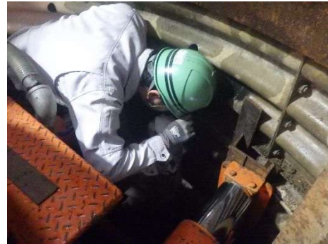
写真.7 ターゲット確認状況
