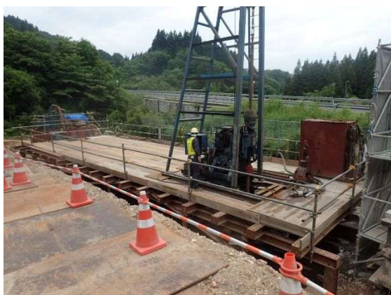
写真. 2 山留作業構台+大口径ボーリング工
