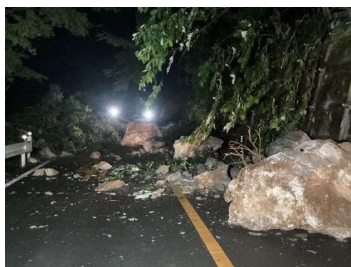
図.2 落石発生時の状況(埼玉県提供)
