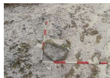
写真.3 落石発生状況(令和7年2月)
