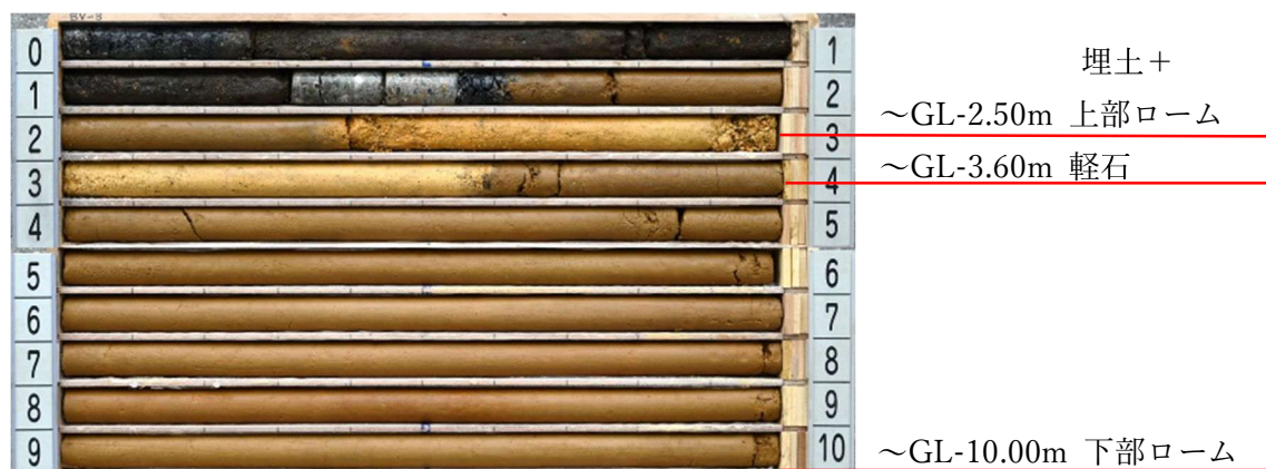
写真.5 ボーリングコア写真
