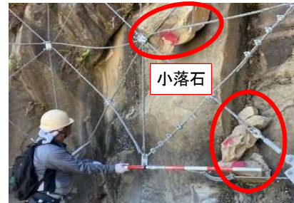
写真.5 ロープ伏工のみで捕捉できない小落石 1)
