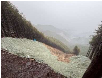
写真. 3 植生マット施工状況
