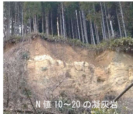
写真. 4 風化凝灰岩の露頭
