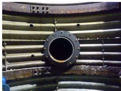
写真. 5 施工完了 (φ300 mm)
