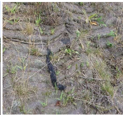
写真.6 客土注入マット近接写真
