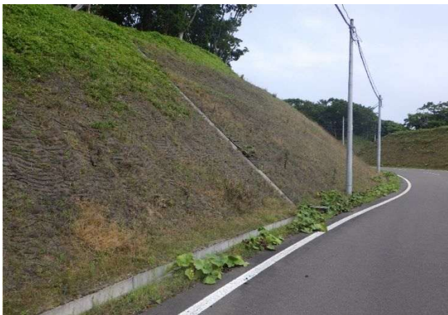
写真.5 周辺地域に敷設された客土注入マット
