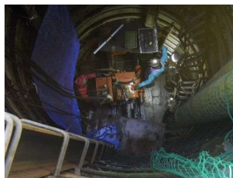
写真. 3 鋼管推進状況
