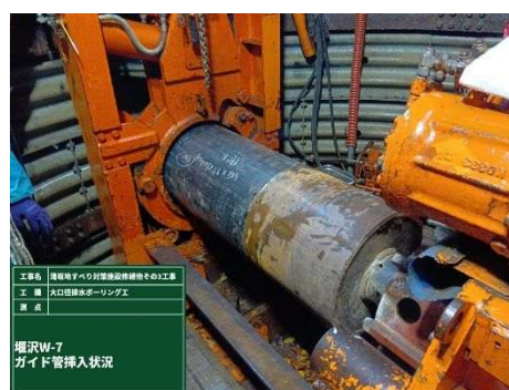
写真. 2 ガイド管挿入状況
