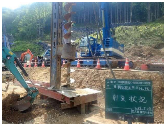
写真. 3 ダウンザホールハンマー工法 (A 工法)
