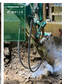
写真. 5 井内掘削・転石粉砕・排土回転バケット
