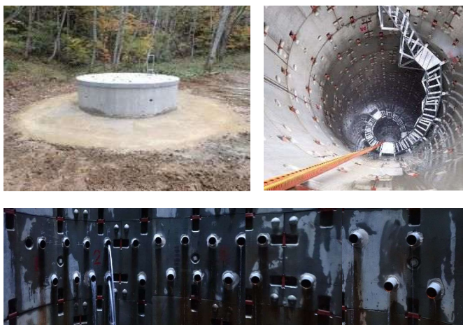
写真.1 WE-1 全景および内部状況
