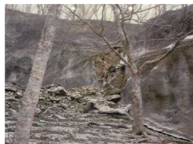
写真.2 吹付工の剝離(令和7年3月)
