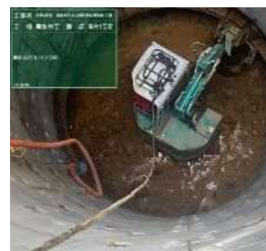
写真. 5 井内掘削・転石粉砕・排土回転バケット
