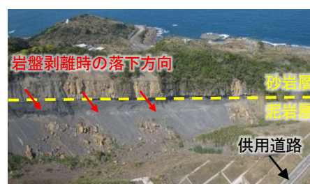
写真4 砂岩急崖が道路に面した例
