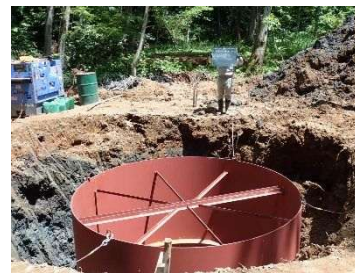
写真. 3 刃口搬入・据付・外周埋戻し状況
