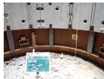
写真. 8 切羽の処理
