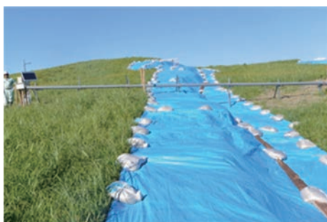
写真 17 計測中の亀裂
