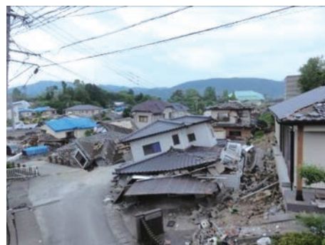
写真2 益城町木山地区の家屋被災
