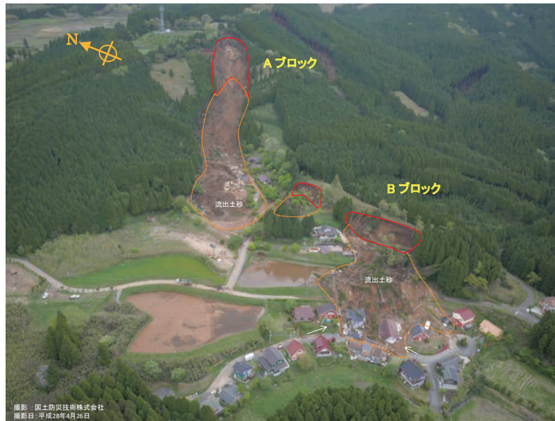
写真 38 火の鳥温泉地区の地すべり群（国土防災技術 資料）
