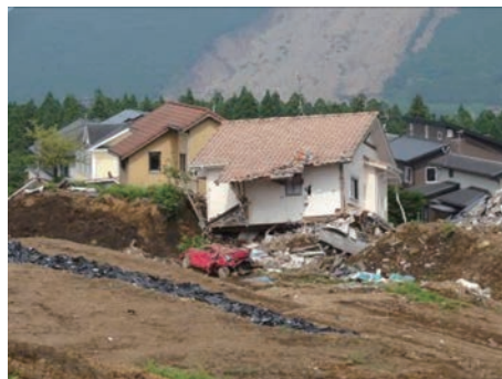
写真 30 土砂流下経路上の被災家屋
