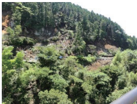
写真7 村道路面が残る崩壊地側方部
