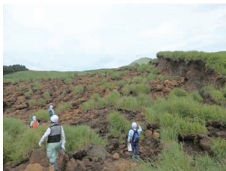
写真 49 地すべり頭部の土塊
