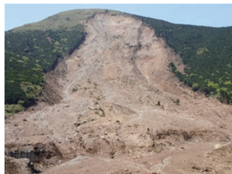
写真 23 6 月の崩壊地 （日本地すべり学会九州支部資料より）
