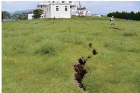
写真32 円丘平坦面頂部の亀裂(火山研究所敷地内)
