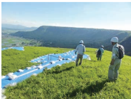
写真 16 ブルーシートで覆われた亀裂
