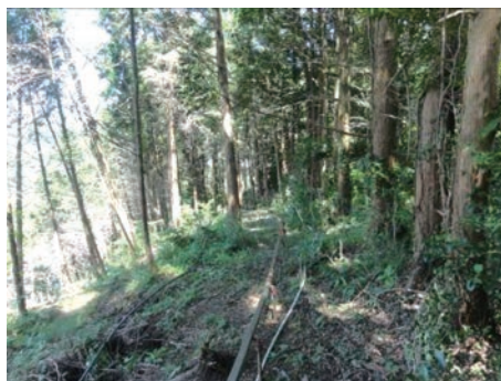
写真10 崩壊地東部の斜面変状
