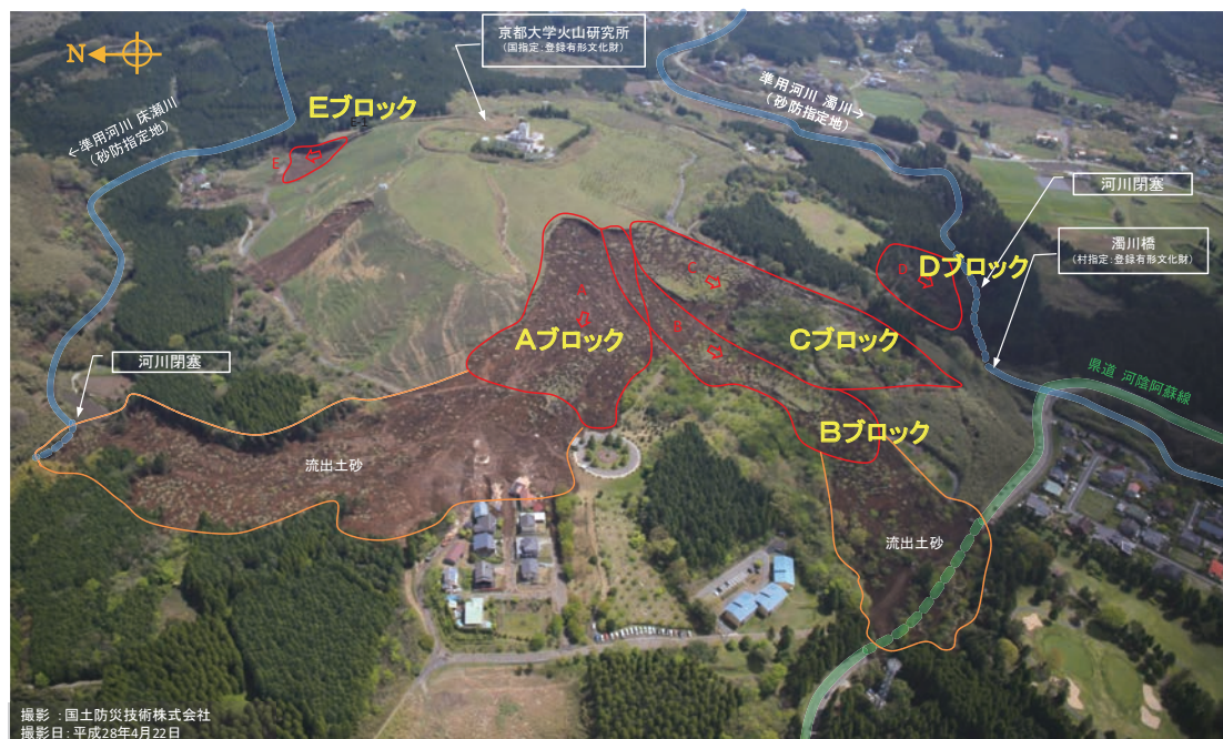
写真 26 高野台地区の地すべり群（国土防災技術 資料）
