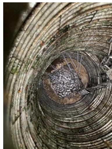
写真 6.10.3 A-3 ブロックの集水井（湛水は見られず、集水ボーリングからの排水も見られる）
