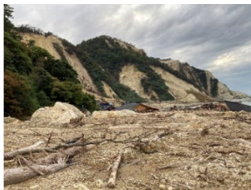
写真5.3 地震による崩壊と豪雨による崩壊・土砂流出の集中した珠洲市清水地区
