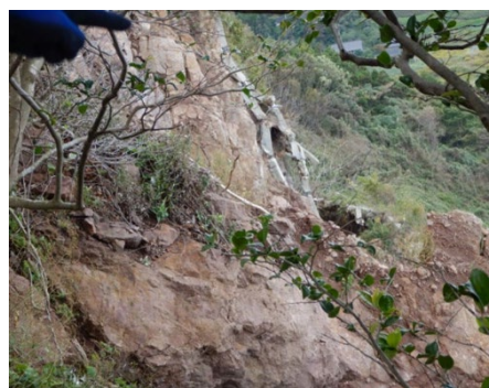
写真 6.8.2 高角度な節理が発達する排水トンネル坑口上方の石英安山岩露岩
