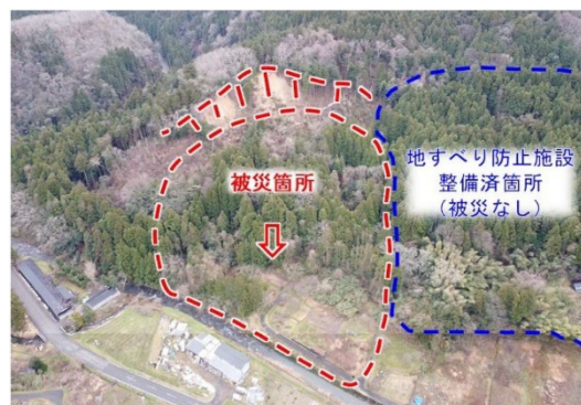
図 6. 4. 2 馬場地すべりの被災状況 15)
