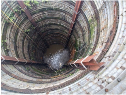
写真6.1.5 既設集水井工の内部（集水ポーリングは2段で、地下水が出ている孔もある）
