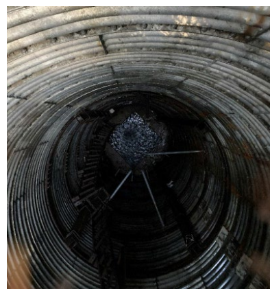
写真 6.11.1 No.9 集水井の状況
