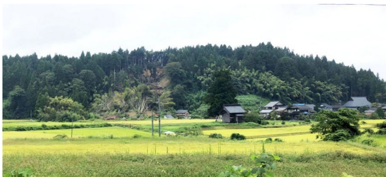
写真 6.6.1 地原地区全景（中央やや左が変状ブロック）
