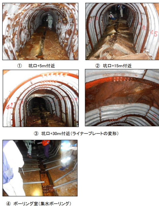
写真 6.8.3 排水トンネル内の状況
