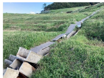
写真 6.9.3 Cブロック末端での表面排水路の折り重なり(同じ箇所 で、右写真ではU字溝が下側のものを前倒させて乗り越えている)
