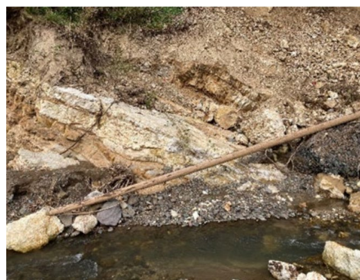
写真 6.7.3 南西方向に傾斜する珪質シルト岩（千谷川右岸）
