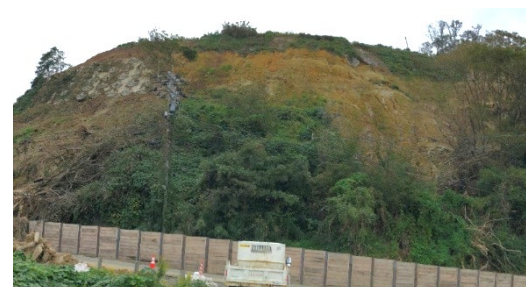
写真 6.2.3 アンカー工の状況（西側のアンカー工は崩壊地の上部）
