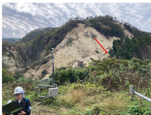
写真 6.7.1 山地斜面で発生した地すべり（中央）と、集水井の設置されていた地すべり地形をなす緩斜面（手前）
