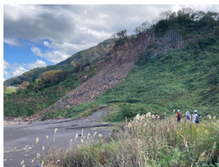
写真 6.8.1 末端ブロックの崩壊と座屈した法枠工（写真中央上とその右）
