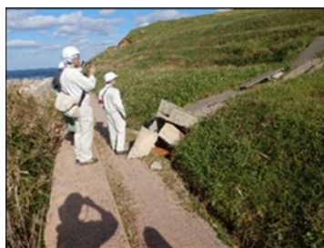
写真 6.9.3 Cブロック末端での表面排水路の折り重なり(同じ箇所 で、右写真ではU字溝が下側のものを前倒させて乗り越えている)
