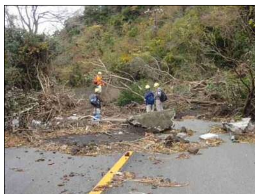
写真7 道路上の堆積土砂
