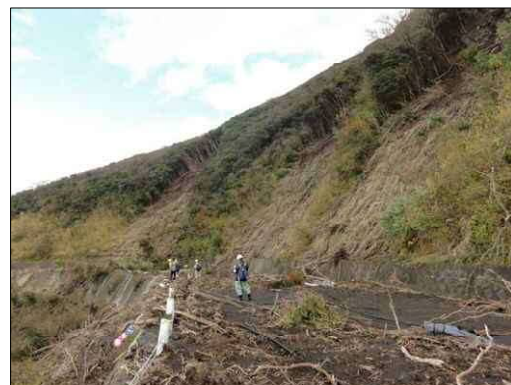
写真2 連続する崩壊地と道路上の土砂および立木の堆積
