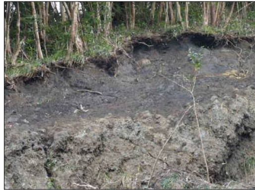
写真9 崩壊頭部の崩壊面に見られる火山灰土壌と風化溶岩
