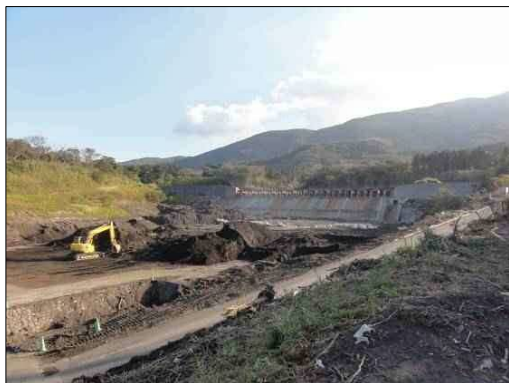
写真 10 大金沢本川堆積工
