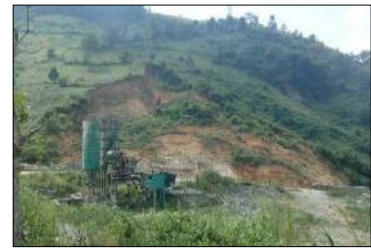
降雨による地すべり ベトナム
