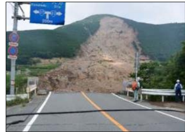
地震による大規模崩壊 日本
