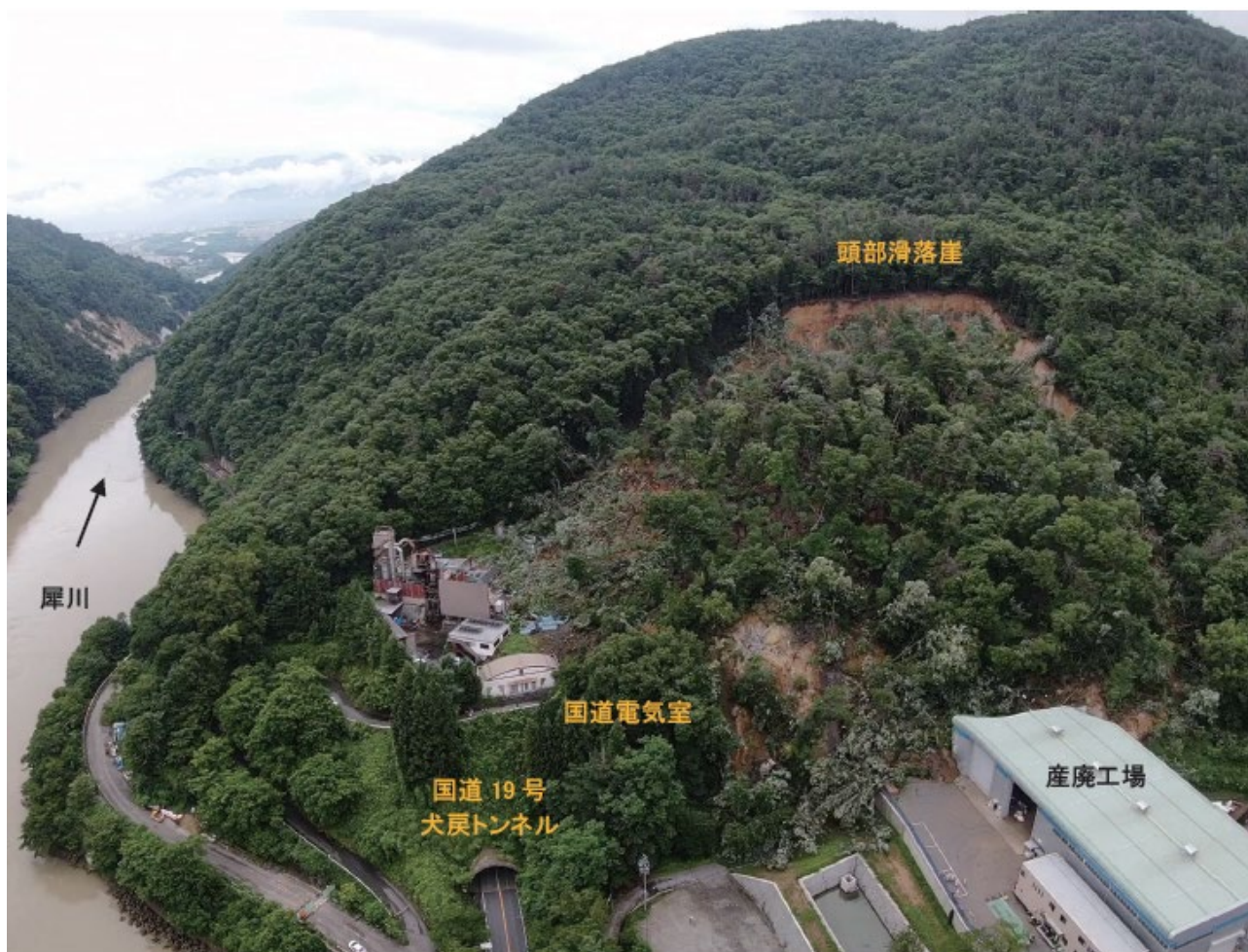
発生直後の地すべり全景（7月6日撮影 提供：長野県土尻川砂防事務所）
