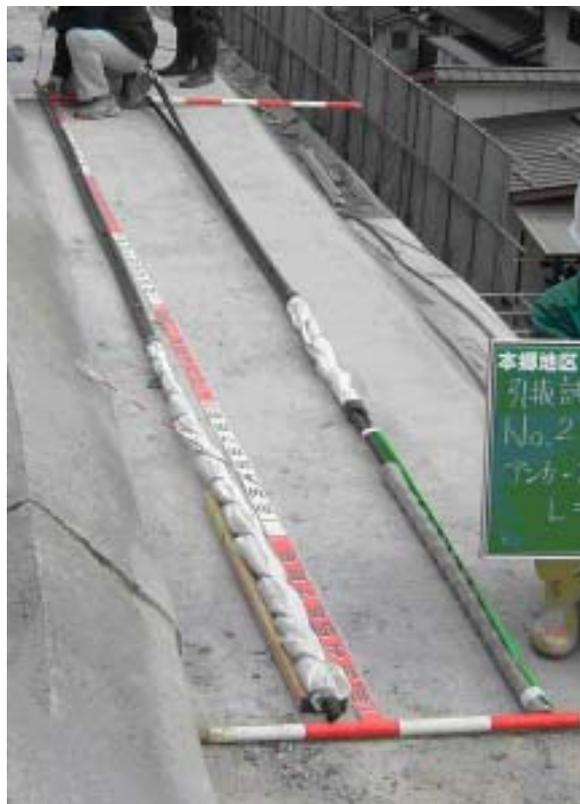
写真 10 基本試験用テンドン(300W型, アンカー孔径 90mm)
